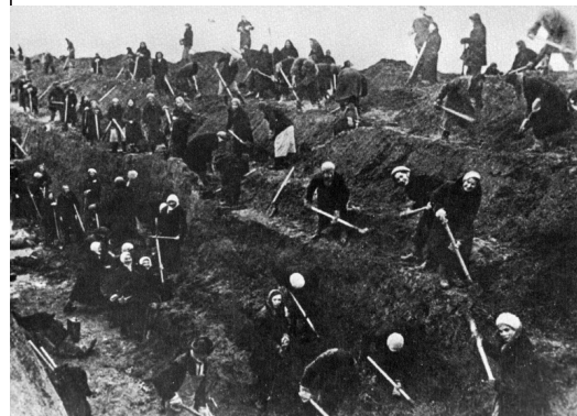
с. 51. Иногда одна лопата, которой орудовал стоящий глубоко внизу человек, взлетала кверху только до половины эскарпа, до приступочки в стене, оставленной для другого человека, тот подставлял другую свою лопату и ждал, пока нижняя передаст ему свой груз, после чего он взметал свою ношу ещё выше, к третьему...
