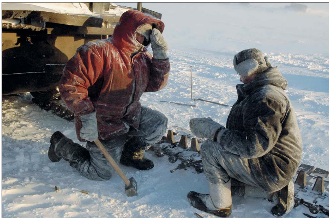
Ремонт на трассе при минус 75°С.
