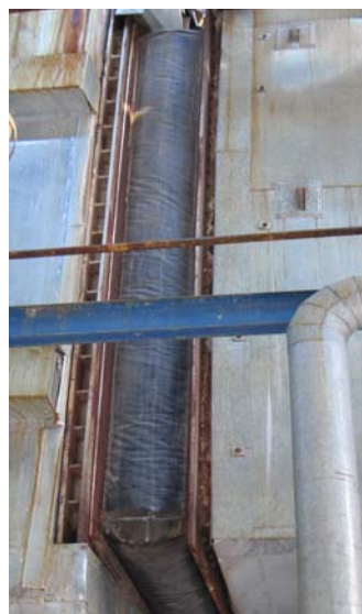
Рис. 4. Тканевый компенсатор с применением газоплотных слоев на основе фторопласта.
