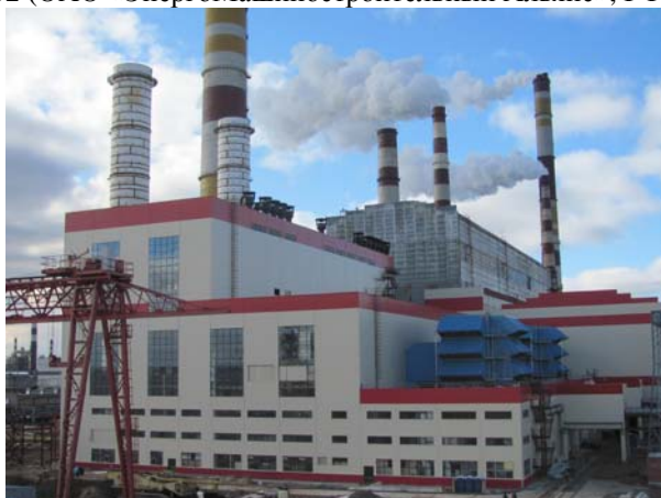
Рис.1. Корпус энергоблока ПГУ-800.
