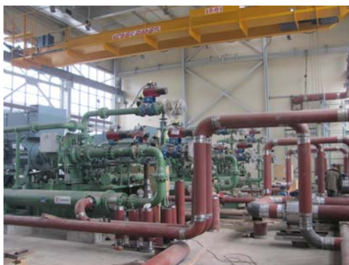
Рис.8. Монтаж оборудования блока компримирования газа
