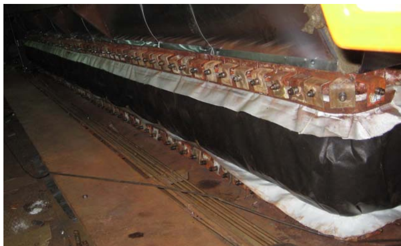
Рис. 1. Компенсатор конвективной шахты котла
