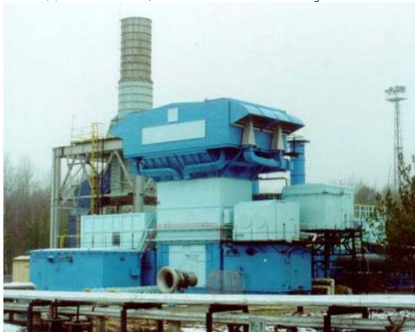
Рис. 1 КВОУ для газоперекачивающего агрегата ГПА-16 «Нева». Первая ступень – прямооточные мультициклоны, вторая ступень – карманные фильтры. 1990-е годы, ОАО «ВНИИТрансмаш».
