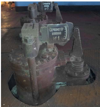
Рис. 3. Механогидравлический золотник
