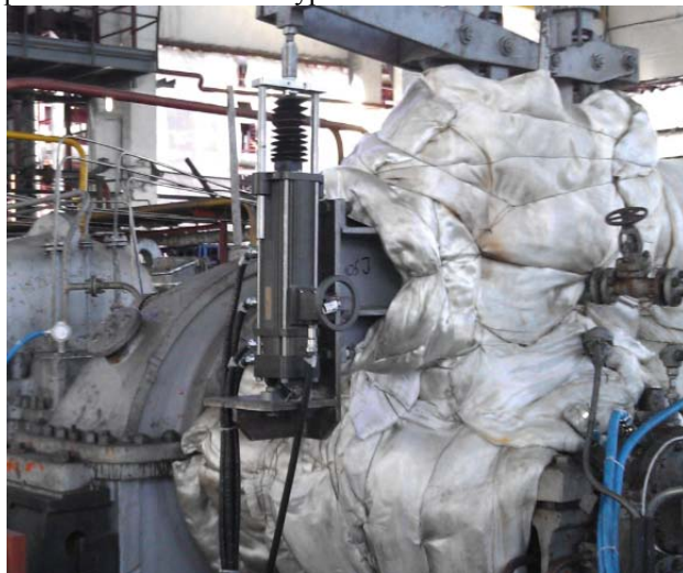
Рис. 5. Пример установки на основной клапан турбины
