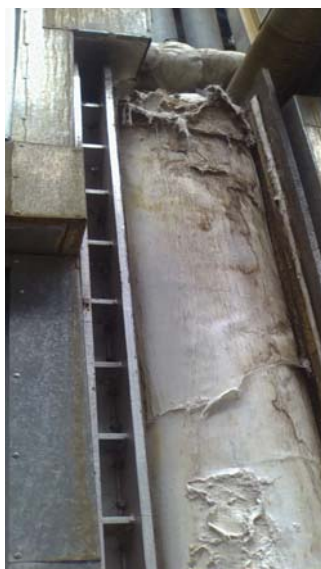
Рис. 3. Тканевый компенсатор с применением газоплотных слоев на основе силикона
