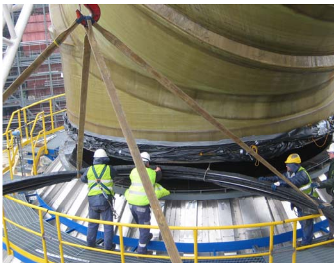
Рис. 2. Монтаж компенсатора
