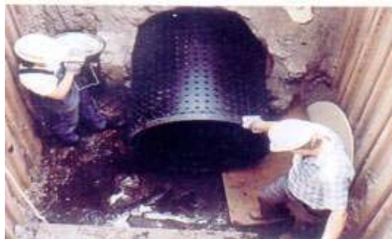
Рис. 4. Ремонт повреждённой трубы
