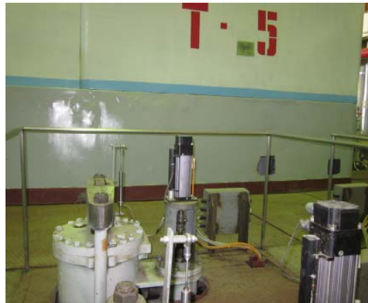
Рис. 4. Электромеханический золотник
