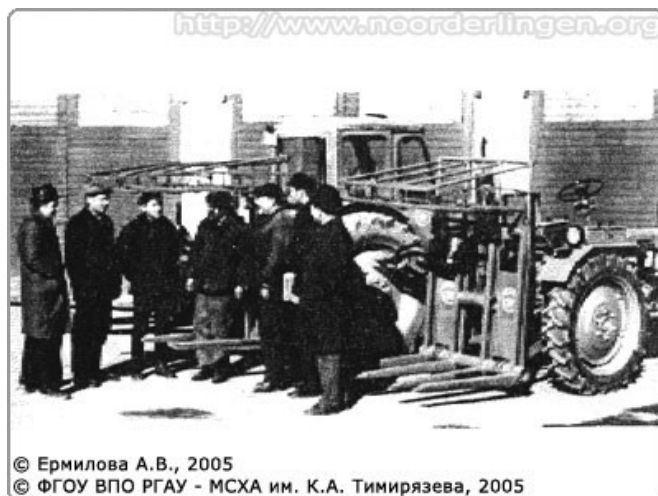
54. Плодоподъёмник, сконструированный группой специалистов, справа – директор учхоза Ермилов В.И., слева – гл. агроном Адрианов В.Н.
