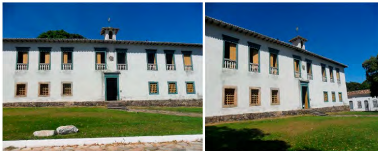
Fachada Principal Fotos: Autor
