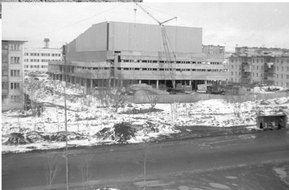
Как позже вспоминал конструктор Валерий Дрозднюк, который входил в группу по проектированию первой высотки Петропавловска, внутри конструкции – монолитное ядро (где лифт и лестница), обстройка – из сборных элементов. Фундамент был сделан в виде плиты, по периметру – сборные колонны, сверху снова сборные плиты. Типоразмеров плит всего 5, колонн – 2 типа. Планировалось застроить такими домами весь район Горизонта, однако это помешало сделать перестройка.
