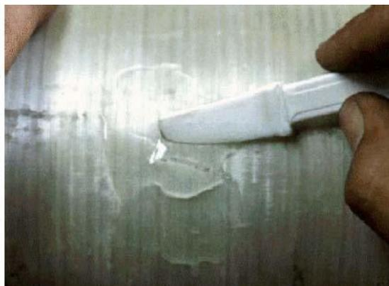
Если требуется более совершенная обработка поверхности, пользуйтесь термоусадочной лентой. Прикрепите кусок термоусадочной однонаправленной ленты, примерно 150 мм длиннее, чем поврежденный
