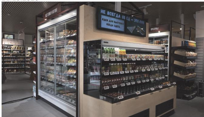
Новинка уже представлена в новом магазине «Магнит» на пристенных холодильных витринах. В основе распашных дверей CISA 19FL - стеклопакеты, произведённые по уникальной технологии “frameless”, благодаря которой достигается максимальный обзор пространства витрины. Механизм открытия/закрытия дверей оснащён механической петлёй, обеспечивающей максимальный комфорт использования двери для покупателей и персонала.
