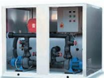
Опция является готовым решением позволяющим организовать циркуляцию хладагента в гидравлическом контуре. В корпусе гидромодуля размещены следующие элементы: блок автоматики, один или два насоса, расширительный бак, аккумулятор, узел подпитки и слива.
