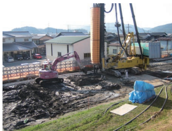
ひのそ島 一日市地区軟弱地盤対策工事
