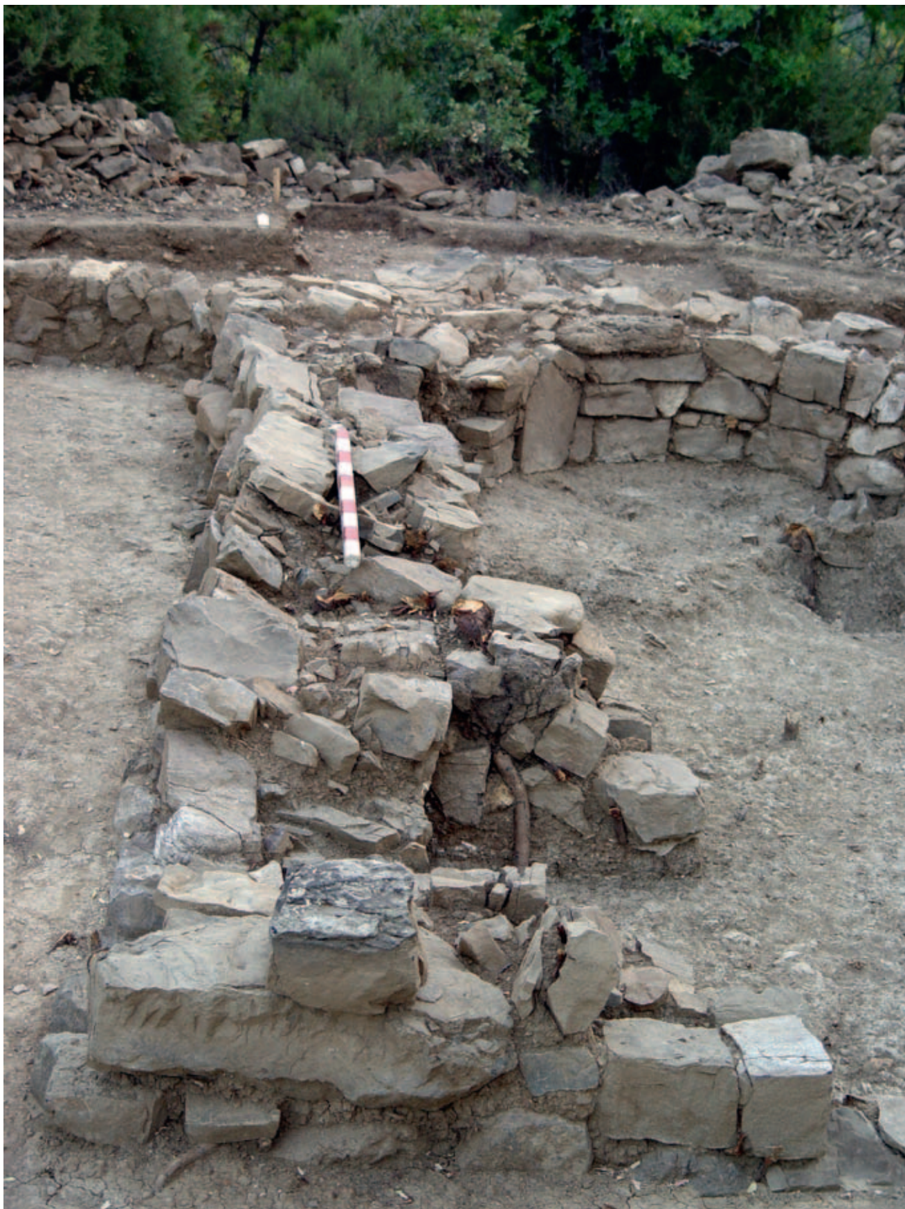
Рис. 1.49. Деформация кладки стены между компартиентами. Общий вид с юго-запада. Fig. 1.49. Deformation of the wall masonry between southern and northern parts of the church, view from southwest.
