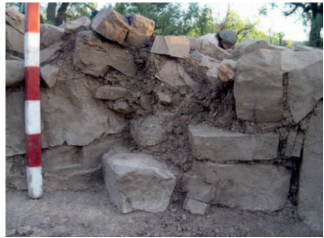
Рис. 1.14. Южная апсида. Фрагмент. Северное заплечико, кладка третьего строительного периода. Вид с юго-востока. Fig. 1.14. Southern apse, fragment, wall masonry of the northern part in the third building period, view from southeast.
