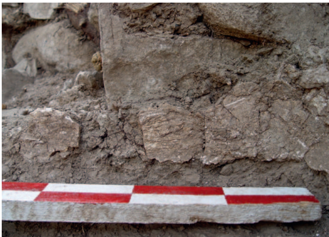
Рис. 1.28. Остатки известковой штукатурки на южном заплечике. Вид с юго-запада. Fig. 1.28. Remains of mortar on the southern part of the apse, view from southwest.
