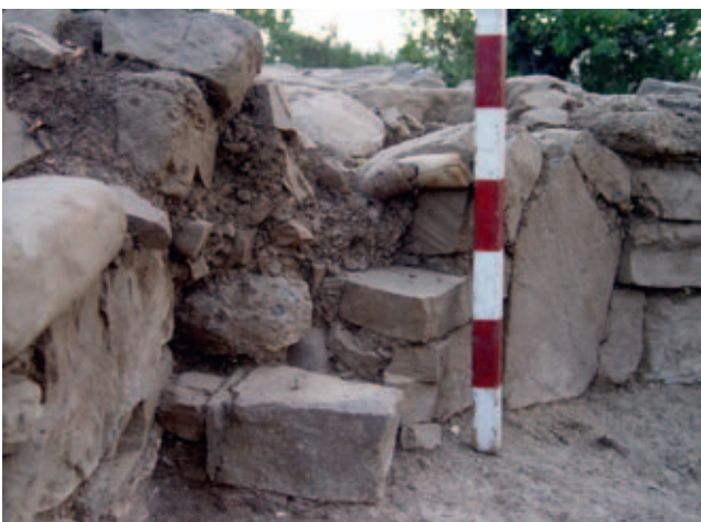
Рис. 1.13. Южная апсида. Фрагмент. Северное заплечико, кладка третьего строительного периода. Вид с юго-запада. Fig. 1.13. Southern apse, fragment, northern part, wall masonry in the third building period, view from southwest.
