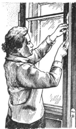
Рис. 4. Герметизация окон
