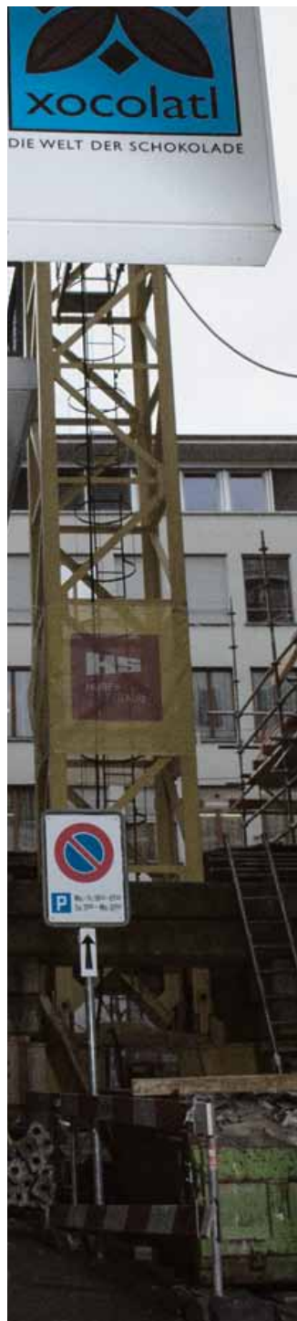
Hat sich mit der Baustelle vor ihrem Laden arrangiert, fürchtet sich aber bereits vor der nächsten: Maren Gnädinger vom «xocolatl» an der Blumengasse.
