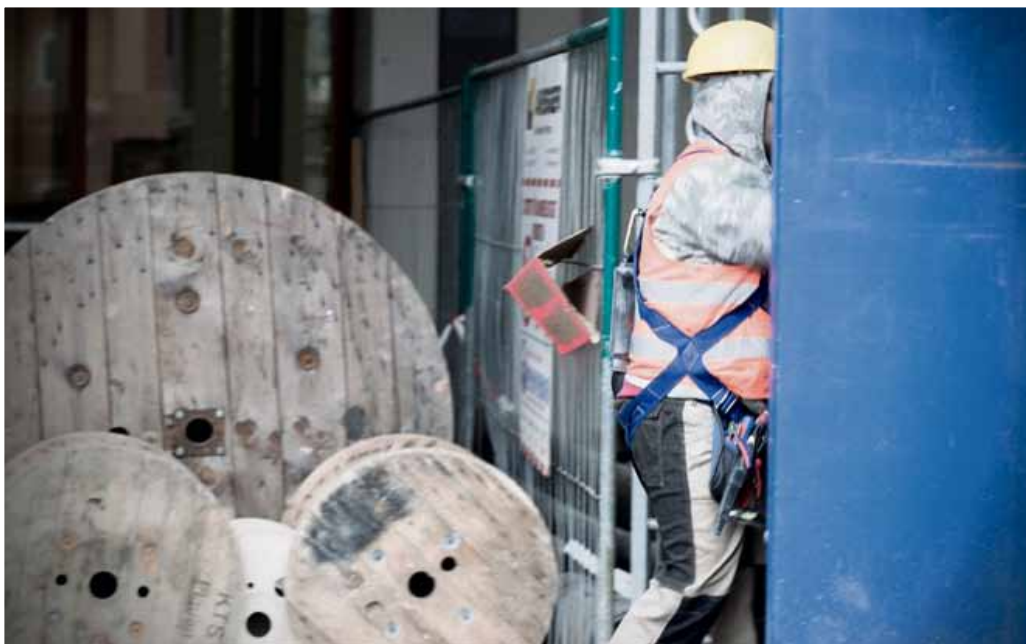
Ein Arbeiter geht durch die Sicherheitskontrolle bei der Grossbaustelle der Messe Basel. (Bild: Michael Würtenberg)
