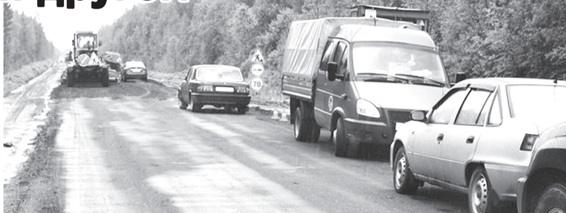
Идёт ремонт автодороги на участке «Летка-Прокопьевка».
