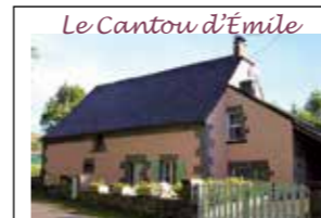
Le Cantou d'Émile Route de la Tour d'Auvergne
