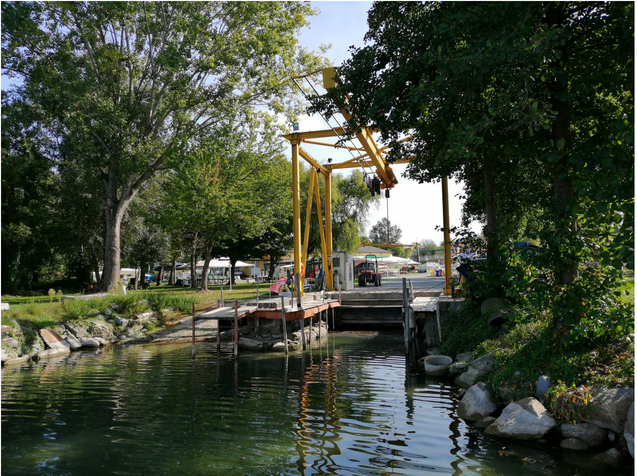
Figura 7: Area varo/alaggio con gru da 30 quintali
