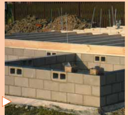
Цоколь из пескоцементных блоков и балочное деревянное перекрытие техподполья
