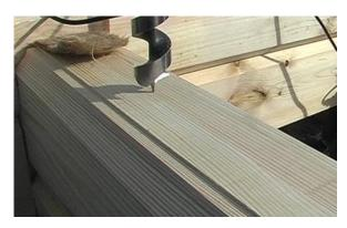
Засверливаем отверстия специальным комбинированым сверлом. Внимание! Засверливание отверстий производить только на земле!
