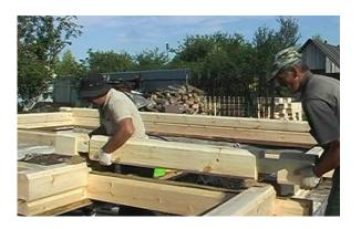
5. Раставляем по посадочным отверстиям Пружинные узлы СИЛА.
