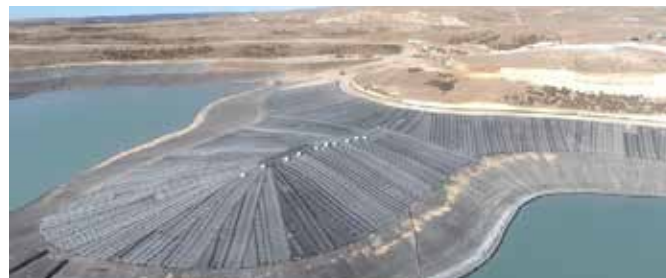
Reservorio de Relaves Impermeabilizado con COLETANCHE®
