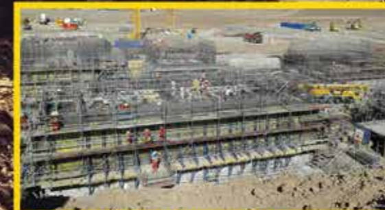
Vista general área Molienda QB2
