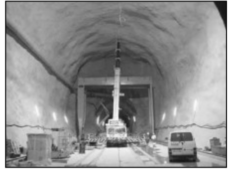
Il fronte di avanzamento lato Amsteg (foto Alptransit Gotthard AG)
