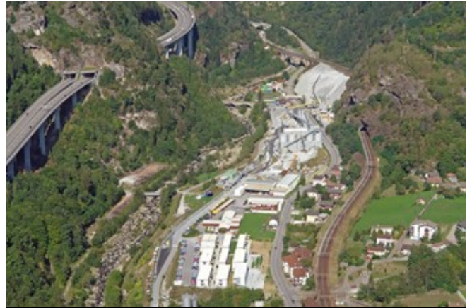
L'area del cantiere Faido della costruenda galleria di base del Gottardo (foto AlpTransit San Gottardo SA)
