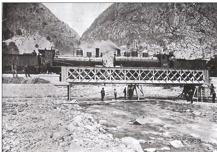
Prove di carico sul ponte sul Vinadia con due locomotive a vapore Gr 451 FS (foto U. Antonelli)
