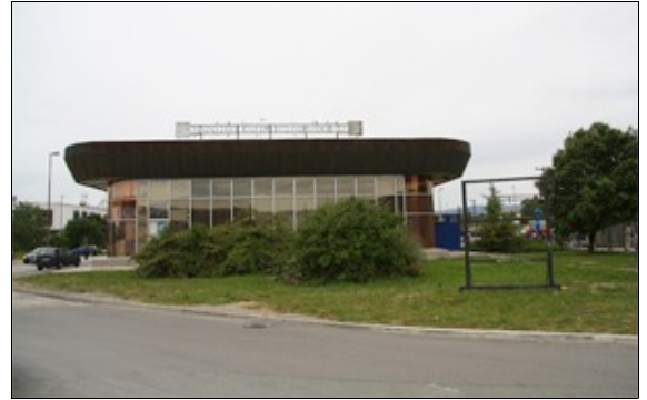
Il fabbricato viaggiatori della stazione di Capodistria (foto D. De Anna)
