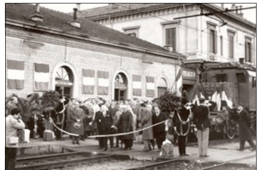
L'inaugurazione della trazione elettrica sulla Udine-Venezia. La locomotiva è la E 428.025 (arch. DLF Udine)
