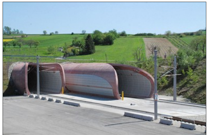
Il Wienerwald Tunnel, con portali stile Star Trek (fonte Die Presse.at)
