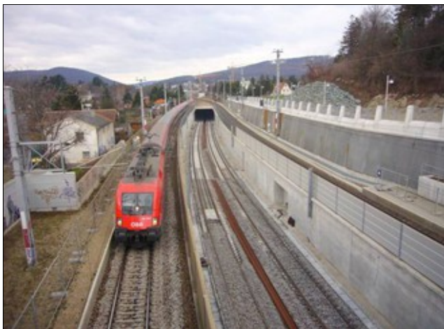
L'ingresso del Lainzer Tunnel (fonte Purkersdorf-online.at)
