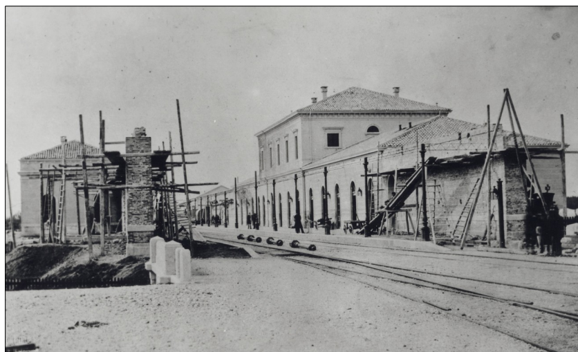
L'unica foto conosciuta, risalente ai primi anni di esercizio 1861-62, della stazione di Udine con l'installazione delle pensiline (Studio Lotze - coll. D. Pittino)
