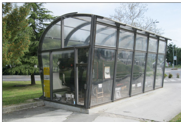
La serra protegge egregiamente a Isola la locomotiva Lok P 3 della Parenzana
