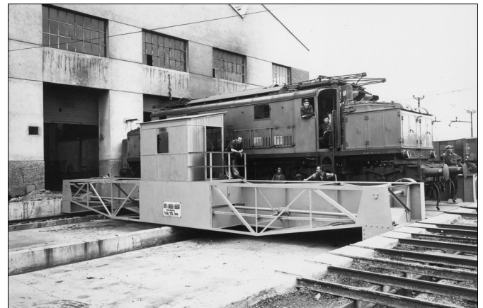
Una locomotiva E 626 sul ponte trasbordatore posto all'ingresso delle officine del deposito locomotive di Udine (Fototeca Civici Musei, Udine. Archivio Brisighelli)
