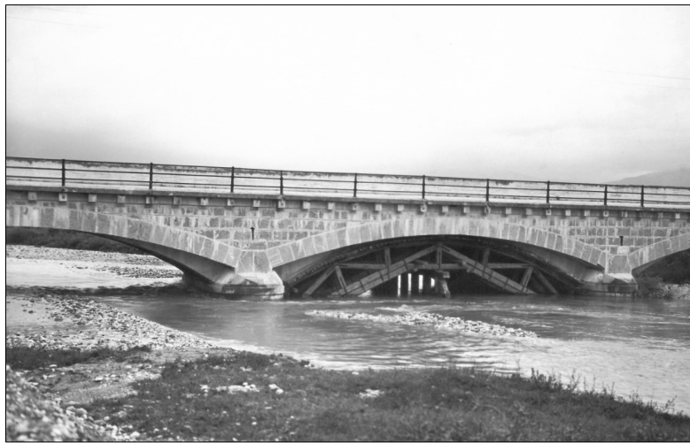
Il ponte sul Malina puntellato nel 1931. Probabilmente i lavori dell'anno prima non furono sufficienti e il ponte venne rifatto con travi in calcestruzzo (arch. FUC)
