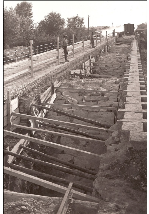
Lavori sul ponte sul Malina nel 1930 (arch. FUC)
