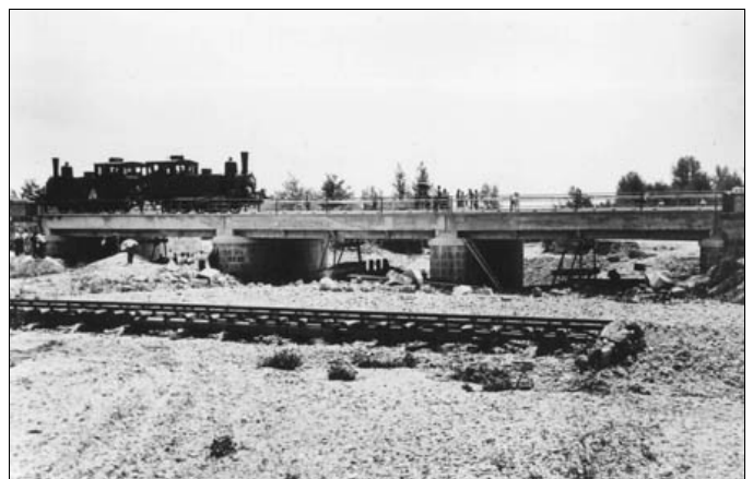
Collaudo con due locomotive del Gr 27 del ponte sul torrente Malina ricostruito con travate in calcestruzzo. In primo piano il guado provvisorio (coll. D. Carlutti)
