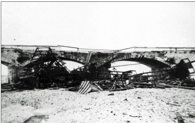
Telai dei vagoni rimasti coinvolti nel crollo del ponte sul torrente Torre (coll. D. Carlutti)
