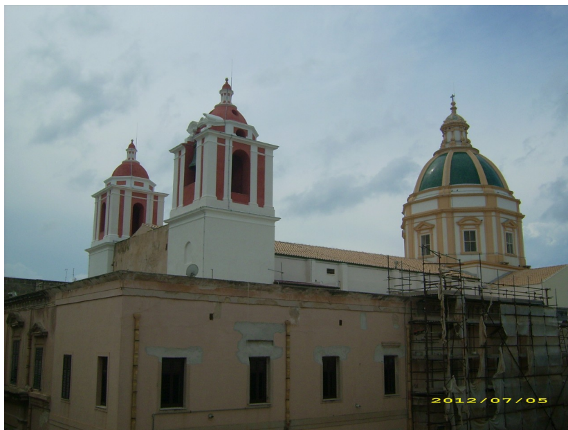
I campanili restaurati
