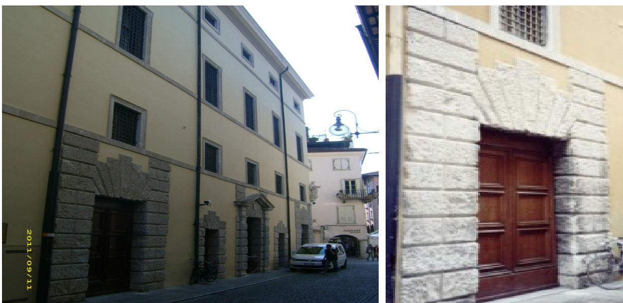
Lato via Pellicerie
