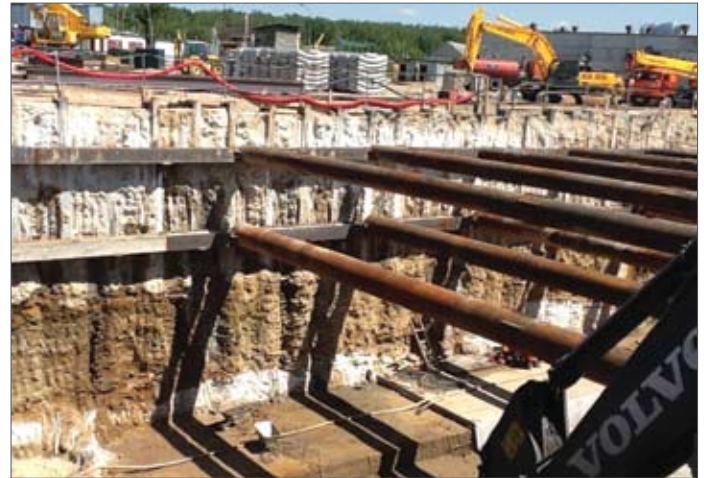
Рис. 8. Ограждение котлована из грунтобетонных элементов
