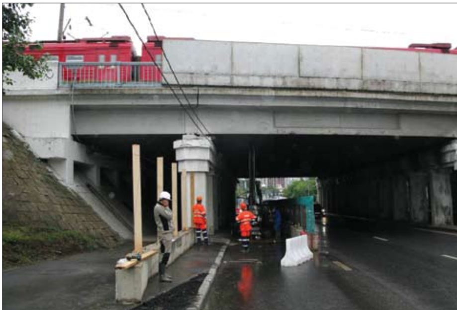
Рис. 5. Общий вид площадки строительства (Москва, ул. Минская)
