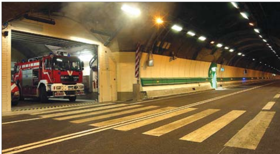
Рис. 9. Пожарный пост, расположенный внутри тоннеля
