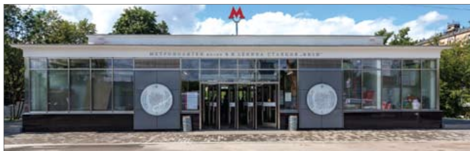
Вестибюль станции «Фили» (Филевская линия) остеклили современными ударопрочными стеклопакетами, которые одновременно отвечают и за температурный режим — зимой сохраняют тепло, а летом спасают от жары и духоты
