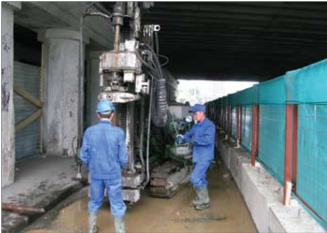
Рис. 7. Производство работ по струйной цементации грунта
