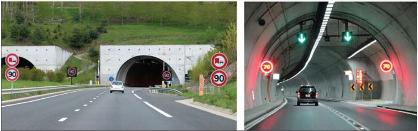
Рис. 5. Дорожные знаки на въезде в тоннель (а) и световые сигналы внутри (б)
