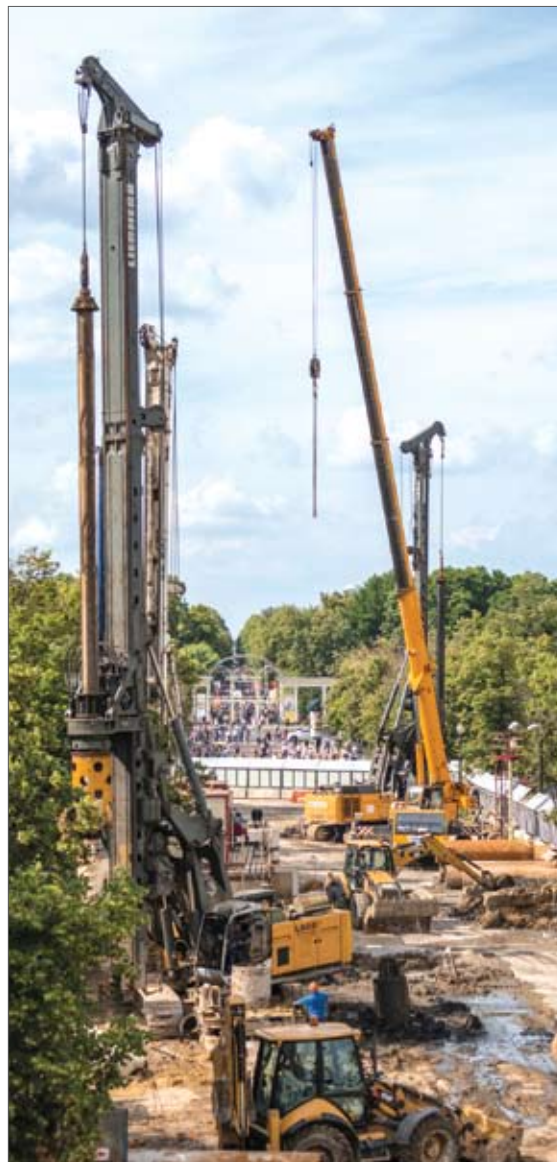
Устройство буросекущих свай для ограждения котлована будущей станции «Стромынка» Большой кольцевой линии.
