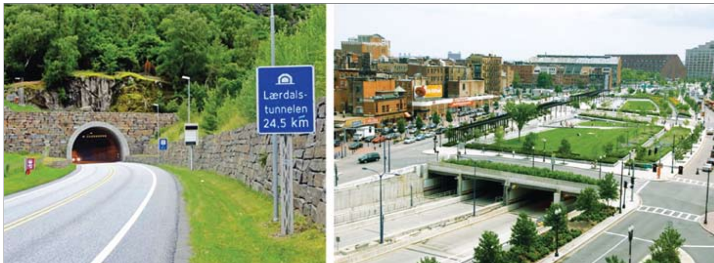
Рис. 1. Крупнейшие автотранспортные тоннели в мире: а – горный тоннель Лаердал в Норвегии; б – городские тоннели Централ Артери в Бостоне, США
