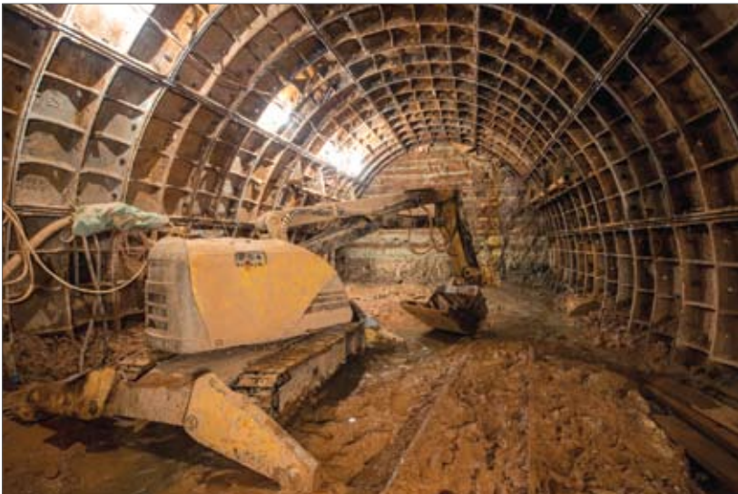
Подземный путь для сооружения пересадки на действующую станцию «Рижская» Калужско-Рижской линии.
