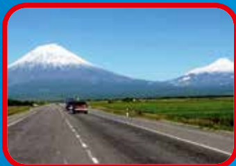
Состояние и ремонт дорог
