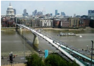
Millennium Bridge i London. Den var først designet til at klare svingninger i det lodrette plan, dvs. i 2D. Problemerne opstod med de vandrette svingninger.
