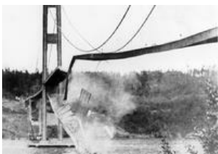
Det mest spektakulære bro-kollaps skete i 1940, hvor Tacoma Bridge blev påvirket af en vedvarende blæst, der langsomt satte brobanen i svingninger, indtil det pludselig løb løbsk og broen styrtede sammen.
