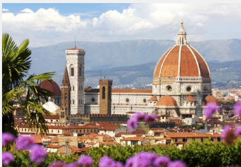
Brunelleschis navn er ikke mindst knyttet til den imponerende kuppel på domkirken i Firenze. Der var konstrueret kuppel før, men aldrig over så stort et rum. Den normale metode ville være at understøtte med trækonstruktioner, mens byggeriet stod på, men det var helt urealistisk med så stor en kuppel. Brunelleschi løste problemet ved at konstruere to kuppel inden i hinanden på en sådan måde, at der bliver et træk udad. Uden lanternen på toppen ville kuppelen åbne sig!
