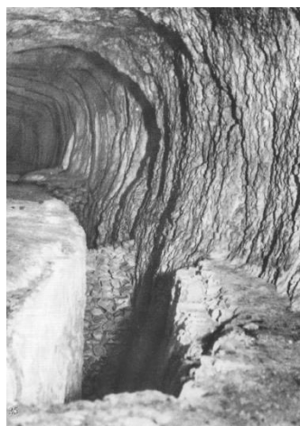
Figur 4. Tunnelinteriør, set mod nord. Vandkanalen ligger langs den østlige kant.
