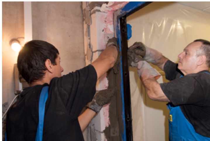
БЕТОНИРОВАНИЕ ЗАЗОРА МЕЖДУ КОРОБКЕЙ И СТЕНОЙ
