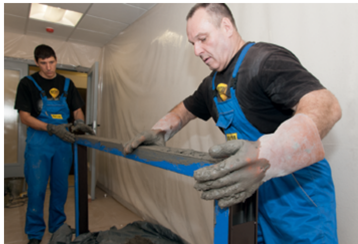
НАБИВКА КОРОБКИ ЦЕМЕНТНЫМ РАСТВОРОМ
