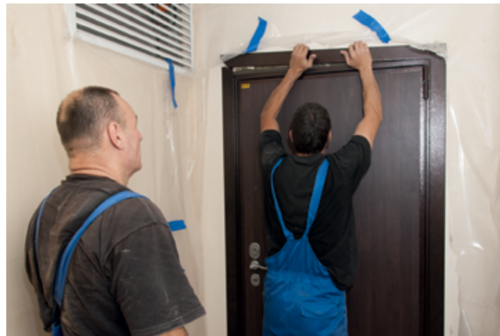
УСТАНОВКА НАЛИЧНИКОВ СО СКРЫТЫМ КРЕПЛЕНИЕМ
