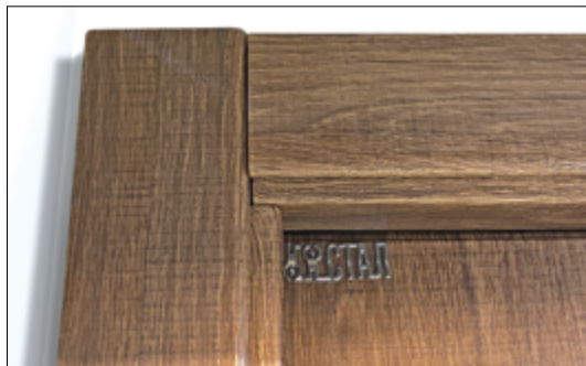
ОБНАЛИЧКА МАКСИМАЛЬНО ЗАКРЫВАЕТ МЕТАЛЛИЧЕСКИЕ ЧАСТИ РАМЫ
