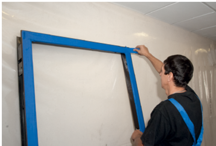
ОКЛЕИВАНИЕ ДВЕРНОЙ КОРОБКИ ЗАЩИТНЫМ ВЛАГОСТОЙКИМ СКОТЧЕМ
