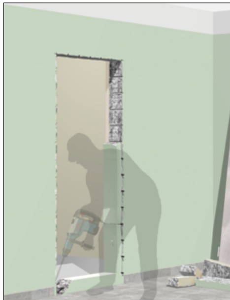
ДОРАБОТКА ПРОЁМА И УДАЛЕНИЕ ПОРОГА
