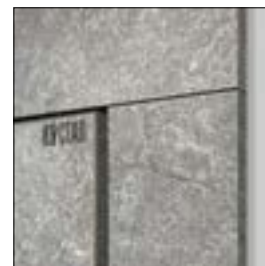
ТОРЦЫ ПАНЕЛЕЙ И НАЛИЧНИКОВ ТОЛЩИНОЙ 16 ММ ОКЛЕИВАЮТ КРОМОЧНОЙ ЛЕНТОЙ
