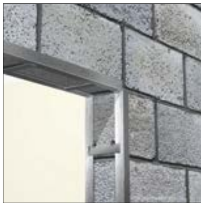
ГОРИЗОНТАЛЬНЫЕ УГОЛКИ ПРИВАРИВАЮТСЯ К ВЕРТИКАЛЬНЫМ.
