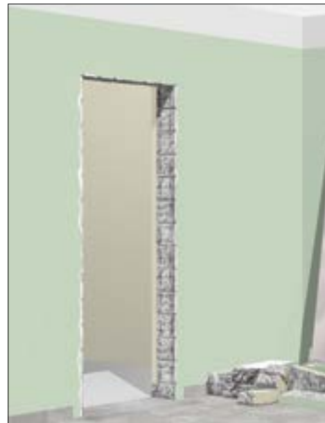
ПРОВЕРКА ГАБАРИТОВ НОВОГО ПРОЁМА
