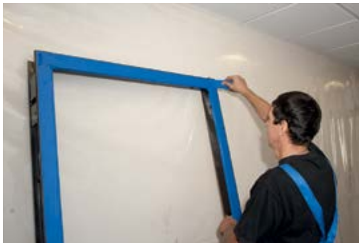
ОКЛЕИВАНИЕ ДВЕРНОЙ КОРОБКИ ЗАЩИТНЫМ ВЛАГОСТОЙКИМ СКОТЧЕМ
