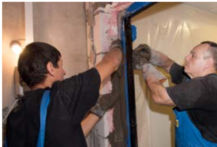
БЕТОНИРОВАНИЕ ЗАЗОРА МЕЖДУ КОРОБКЕЙ И СТЕНОЙ
