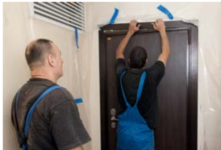
УСТАНОВКА НАЛИЧНИКОВ СО СКРЫТЫМ КРЕПЛЕНИЕМ
