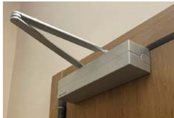
ВАРИАНТ РАСПОЛОЖЕНИЯ ДОВОДЧИКА НА ПОЛОТНЕ ДВЕРИ
