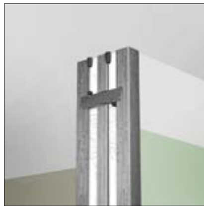
ВСЕ ЭЛЕМЕНТЫ УСИЛЕНИЯ СВАРИВАЮТСЯ МЕЖДУ СОБОЙ ПЕРЕМЫЧКАМИ
