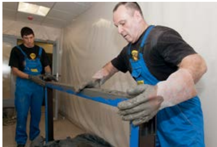
НАБИВКА КОРОБКИ ЦЕМЕНТНЫМ РАСТВОРОМ
